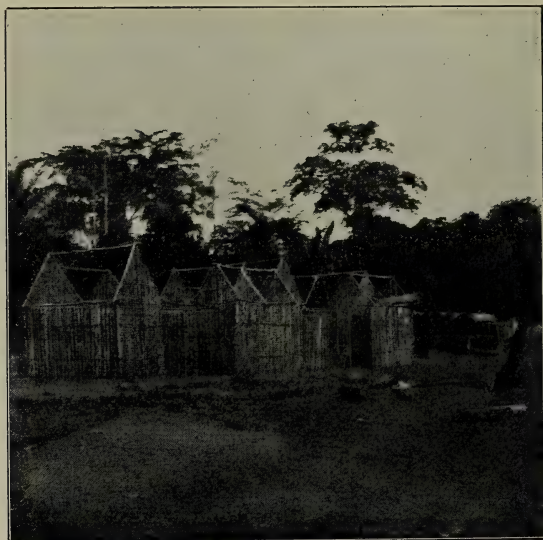
Im Bau begriffene Negerhütten.
